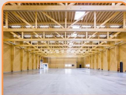
Bâtiment Industriel I+R
